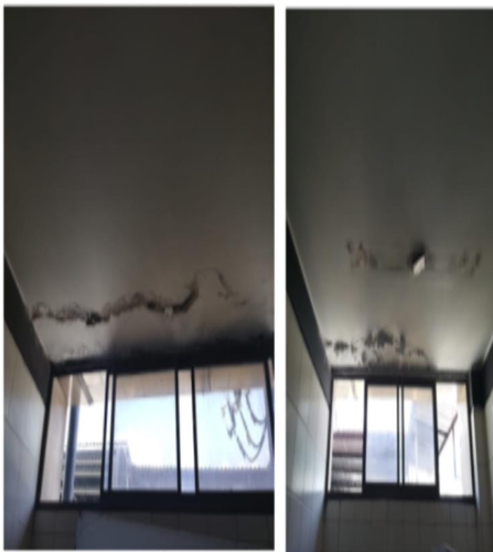
Imagen: Humedad en el techo en el baño de hombres y mujeres.
