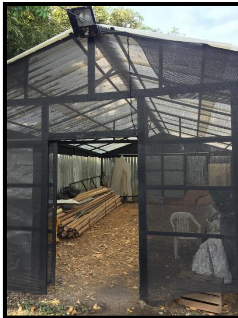
Imagen 7. Interior del cobertizo. UNIMINUTO COA - Buga.
