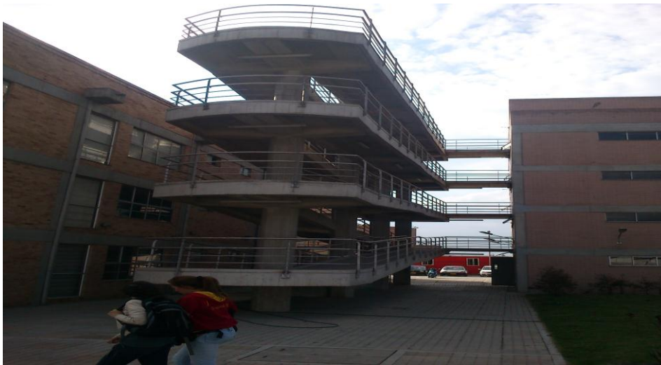
Ilustración 17 Rampa Emergencia Edificio
