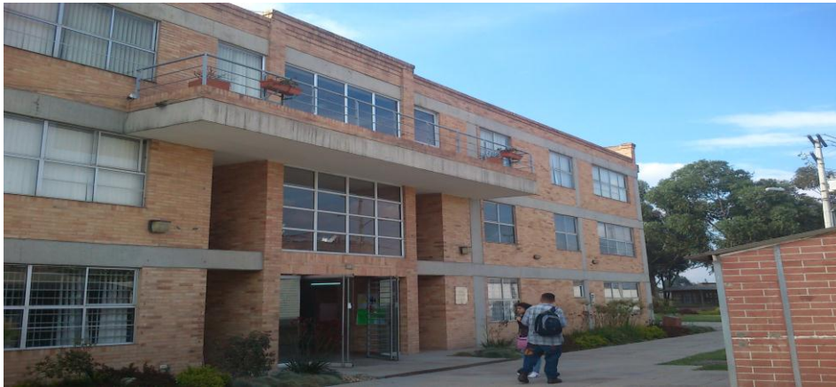
Ilustración 16 Entrada Principal Edificio
