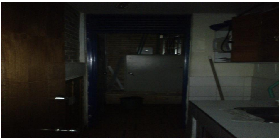
Ilustración 21 Cuarto Eléctrico Primer Nivel Edificio
