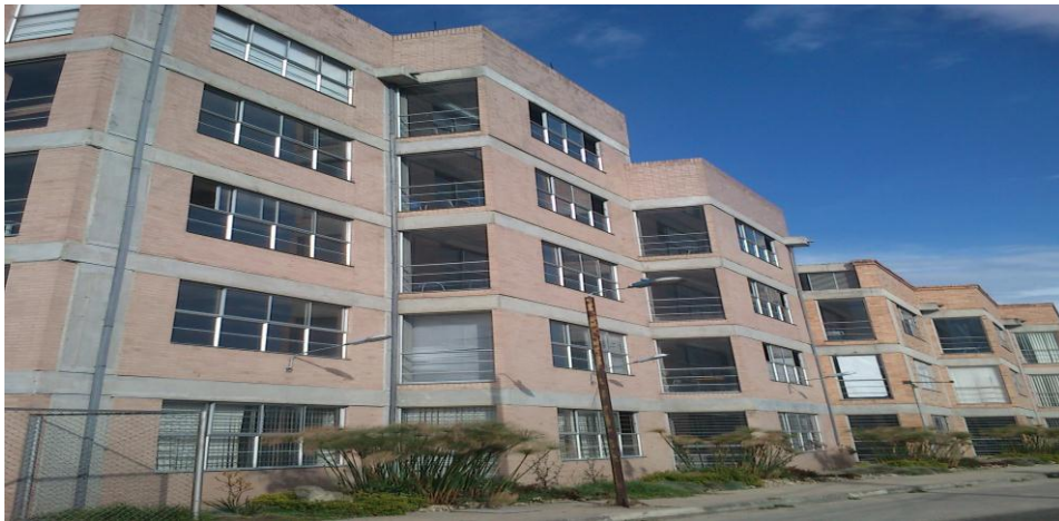
Ilustración 20 Costado Lateral Izquierdo Edificio
