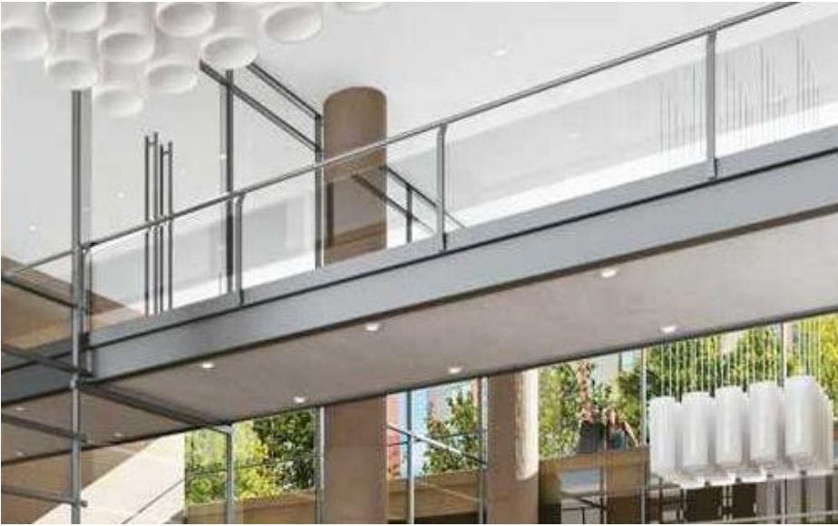
Imagen1. Baranda en vidrio de seguridad, fuente proyecto Amarilo año 2016
